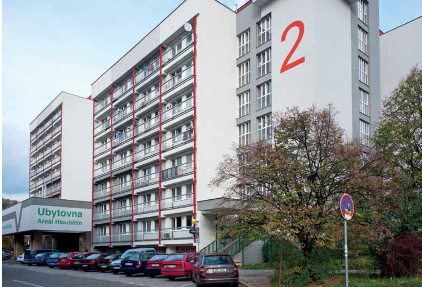
Paneláky tu jsou, teď záleží, jak se o ně budeme starat (opravená ubytovna v Praze-Hloubětíně)
